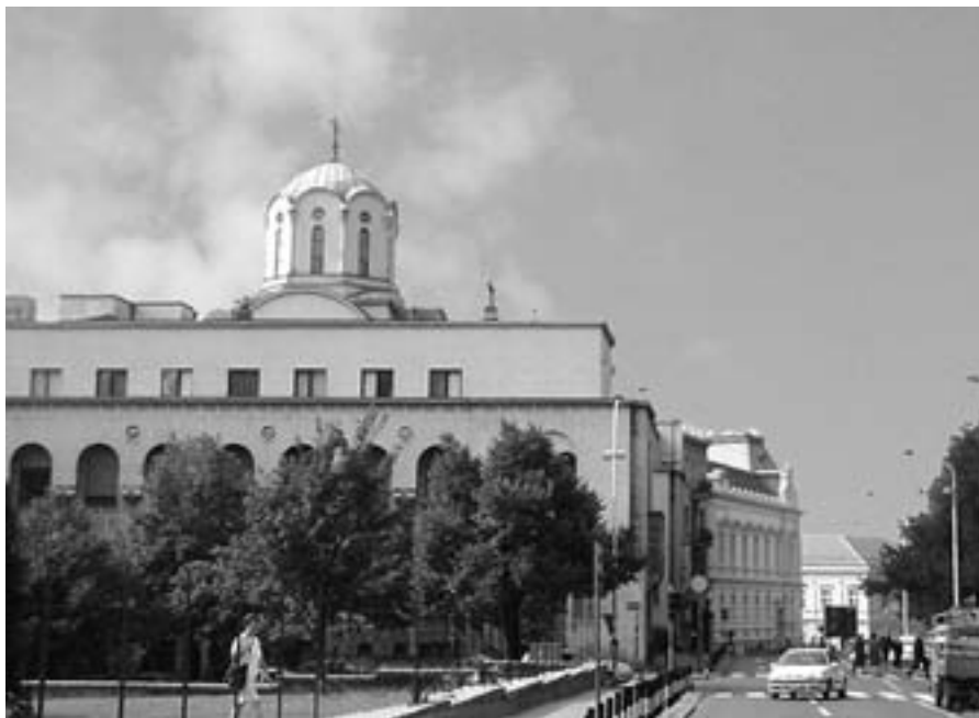
У Кнежевом конаку (данас Патријаршијски двор) био је смештен француски конзул 1838. године
