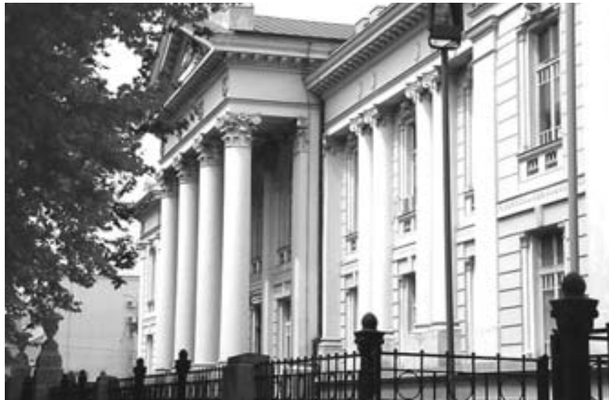
Зграда Универзитетске библиотеке “Светозар Марковић” подигнута 1926 године - Арх. Драгутин Ђорђевић и Никола Несторовић
